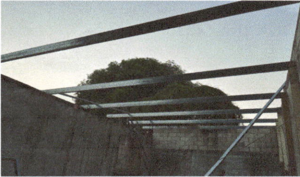
Foto 1: Sustitución de lámina acanalada, por lámina troquelada aluzinc calibre 26 en módulo de aula y sustitución de soporte de madera por metal.
