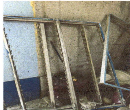
Foto 4: Sustitución de ventanas de aluminio y vidrio de paletas por ventanas de pvc. Y vidrio corredizo en módulo de la dirección.
