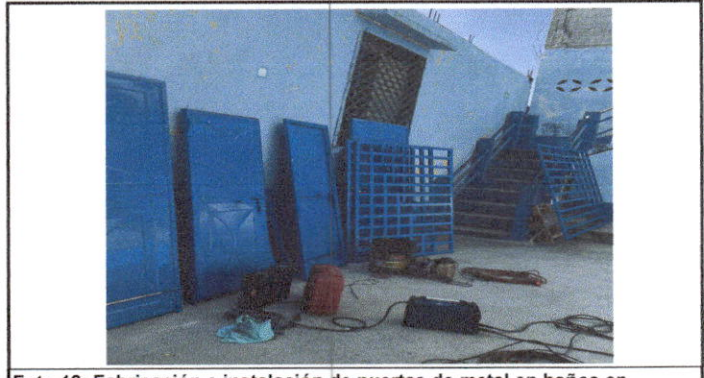
Foto 12: Fabricación e instalación de puertas de metal en baños en módulos 1 y 2 de aulas.
