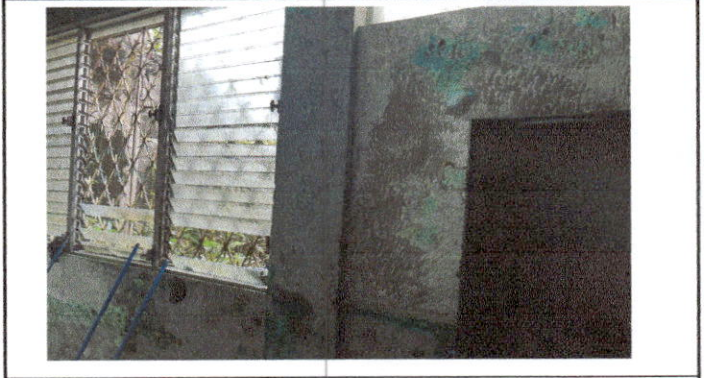
Foto 8: Repello en muro en módulos 1 y 2 de aulas.
